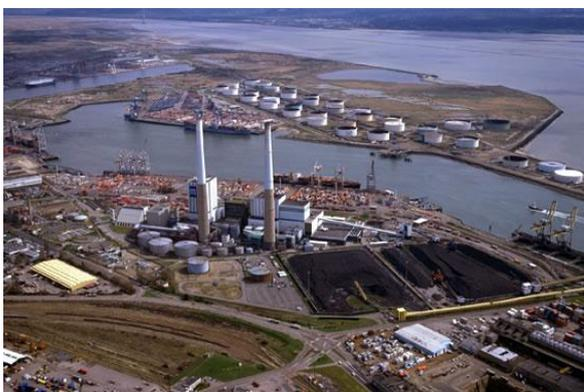
Dans une centrale thermique à flamme (charbon, bois, pétrole), l'énergie chimique des combustibles est transformée en énergie thermique pour produire de la vapeur d'eau qui entraîne une turbine (énergie mécanique). un alternateur la transforme en énergie électrique.
